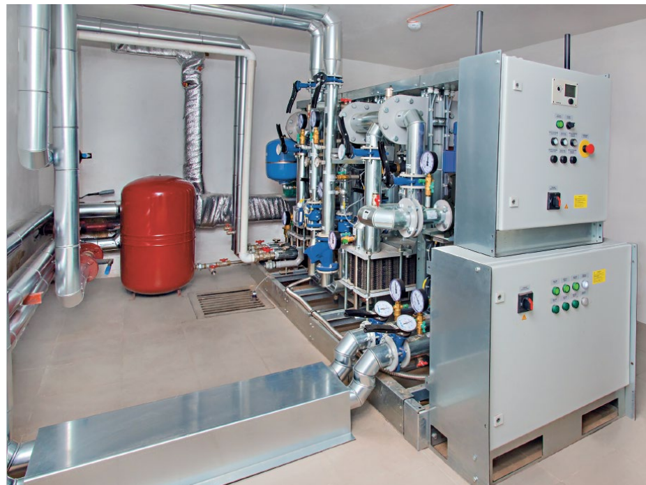
ML-3. Тепловой пункт мощностью 230 кВт для многоквартирного жилого дома (59 квартир)
